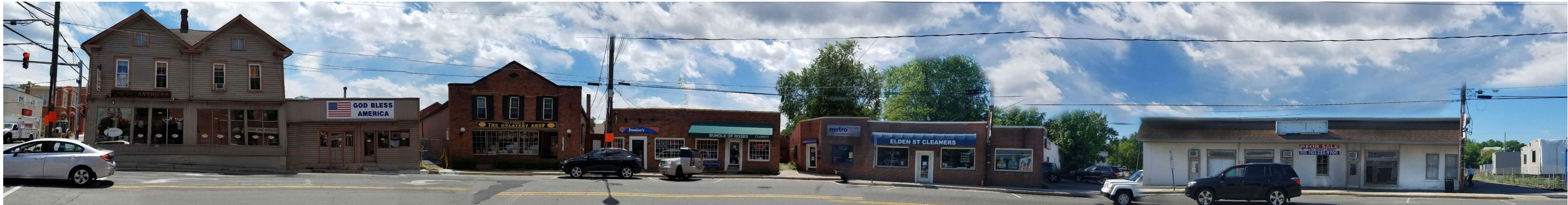
1| EXISTING STREET VIEW N.T.S.
