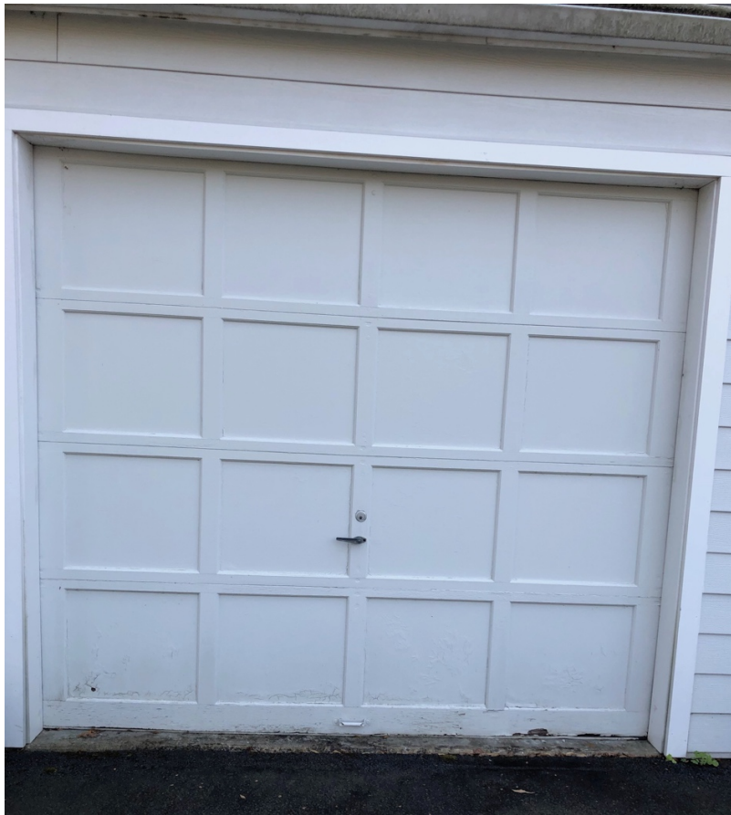
Existing Garage Door
